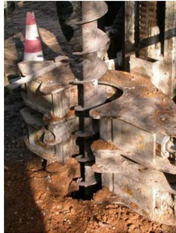
Figure 14 Tarière utilisée pour la fabrication des pieux
