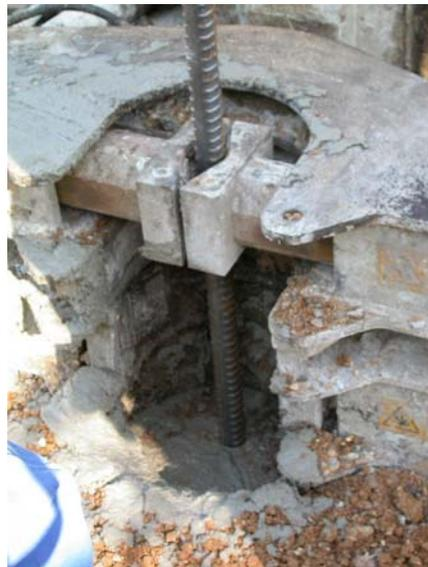
Figure 23 Détail de maintien à la verticale de la barre GEWI
