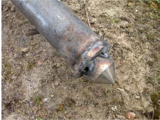
Figure 18 Pointe soudée au bout du tube de logement du pieu 2
