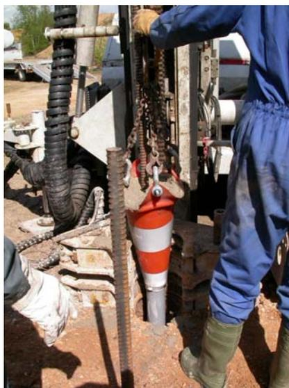
Figure 22 Dispositif utilisé pour le bétonnage des pieux d'ancrage
