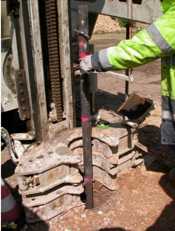
Figure 16 Installation du tube en acier 52/60 mm pour les pieux d'essai
