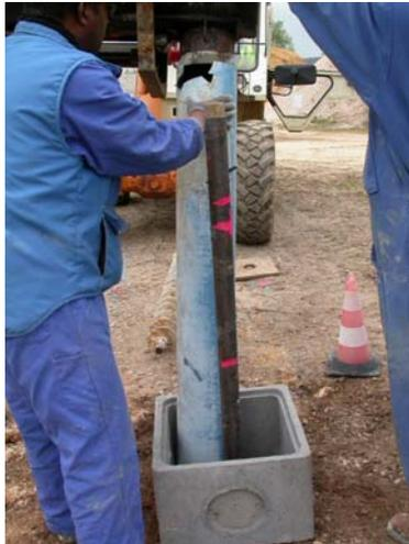
Figure 19 Mise en place de la rehausse du pieu 1
