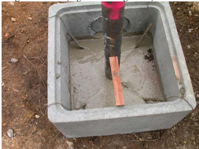
Figure 20 Détail de la tête du pieu 1 avant le coulage
