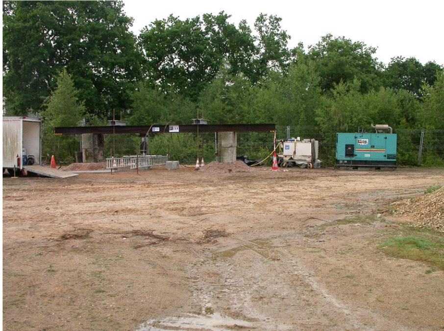
Figure 24 Vue d'ensemble du chantier ; système de chargement, groupe électrogène, centrale hydraulique, bungalow (système d'acquisition),
