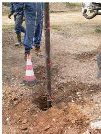
Figure 17 Blocage du tube de logement dans le pieu 1
