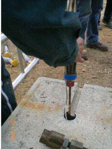
Figure 26 Installation de l'extensomètre
