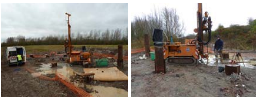
Figure 4: Réalisation du sondage pressiométrique PR1 le 08 décembre 2011
