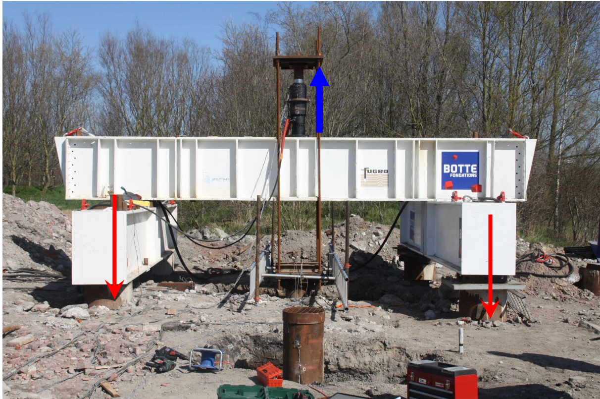
Figure 12: photo du montage d'un essai de chargement en traction
