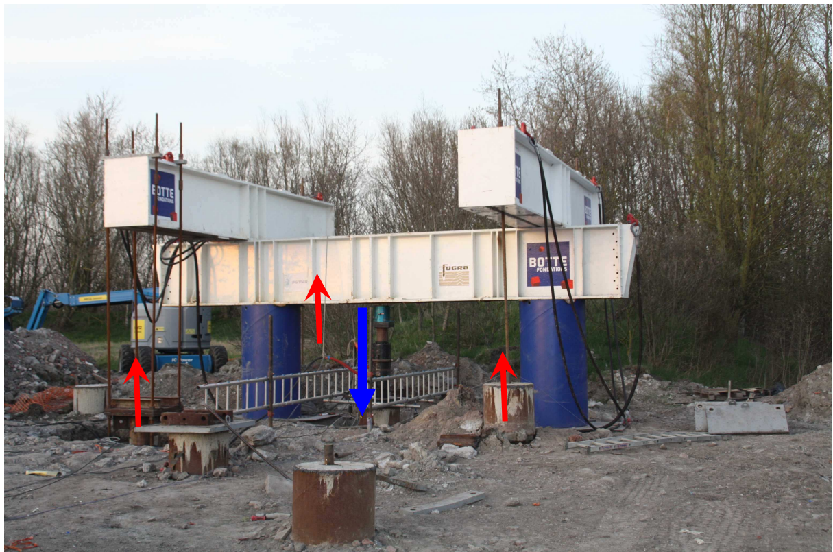
Figure 11 : photo du montage d'un essai de chargement en compression
