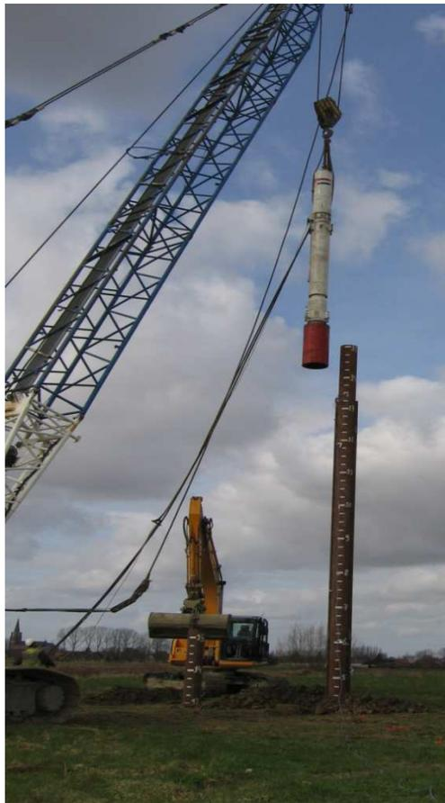
*Figure II-12 : Battage d'un pieu métallique tubulaire (Merville)*
