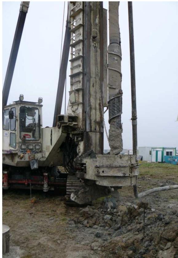
*Figure II-14 : Réalisation d'un pieu vissé moulé (Franki Fondation)*
