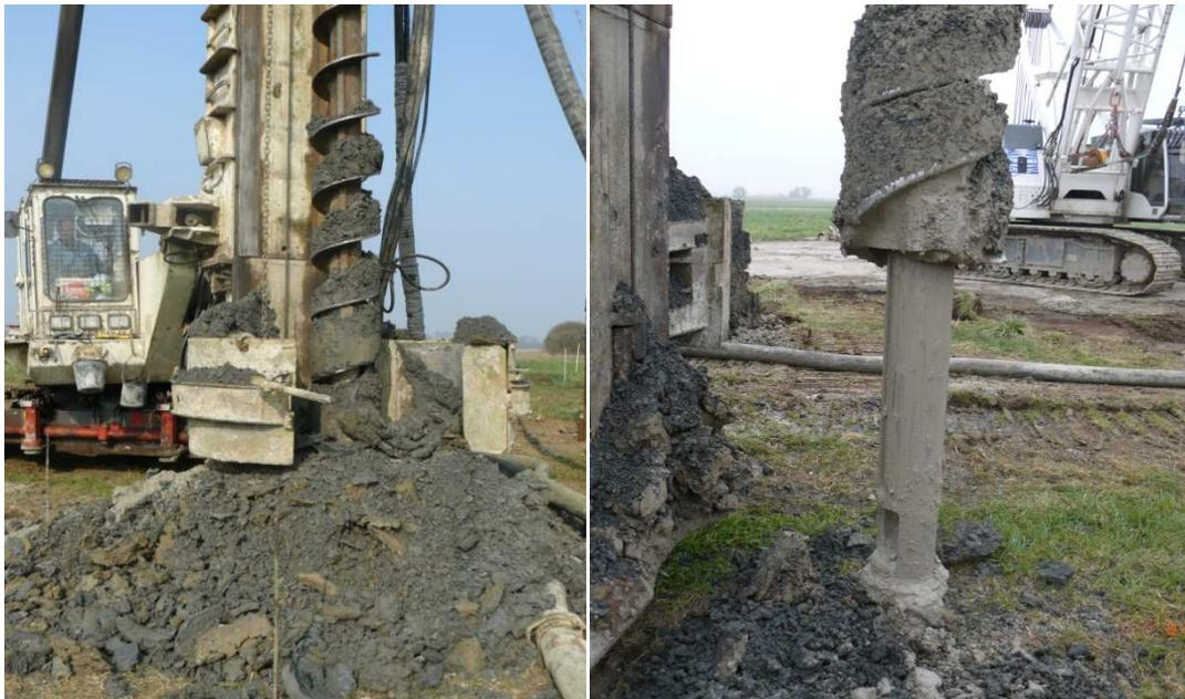
*Figure II-13 : La tarière creuse en action et avec tube de bétonnage déployé*
