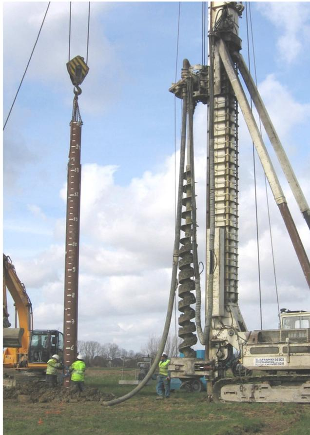
**Figure 1.1.** Installation de pieux battus et forés sur le site de Merville
